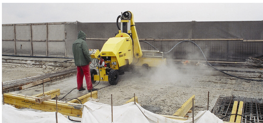
Hidrorazaranje gornje betonske ploče Conjetovim 363 Robotom
